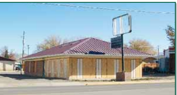
Montrose • 1015 S. Townsend Avenue
