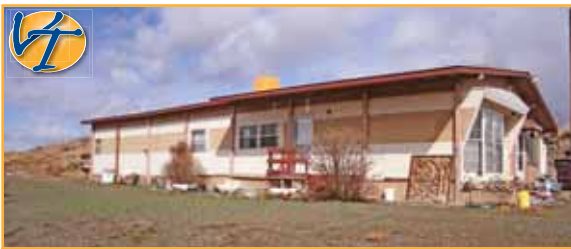
Montrose • 66100 Landfill Road
